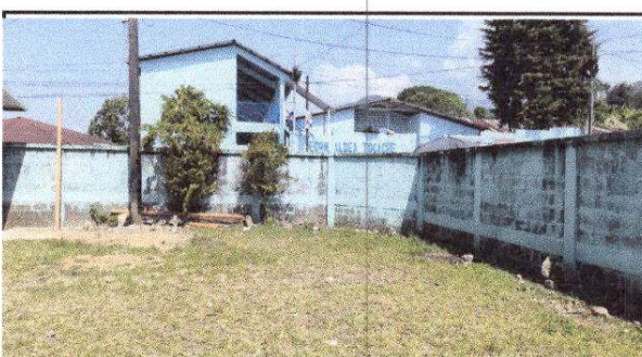
FOTO 12: Pintura en muros exteriores e interiores
