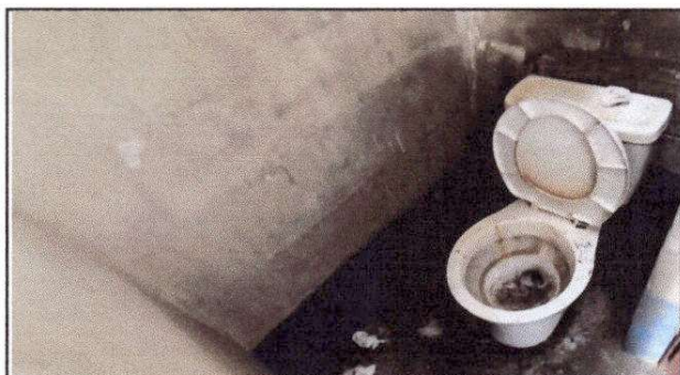
FOTO 3: Sustrucción de azulejo
