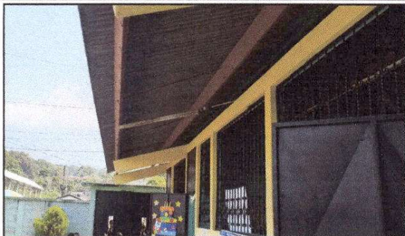
FOTO 7: Sustrucción de canal de metal, Reparación de bajada de agua pluvial, tubo PVC 3" y Sustrucción de soporte o pescante de metal para canal.
