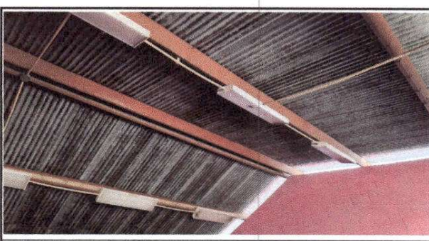
FOTO 6: Mantenimiento a estructura de soporte de metal
