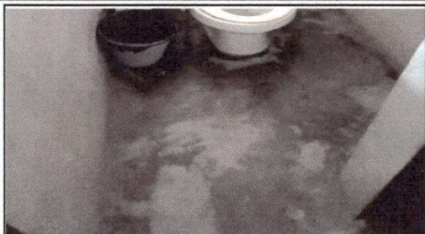
FOTO 1: Sustrucción de piso cerámico
